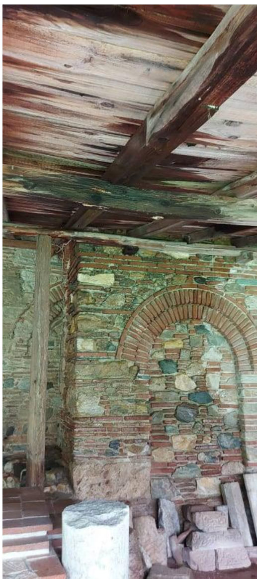
Место каде има протекување на кровот на отворениот јужен трем
