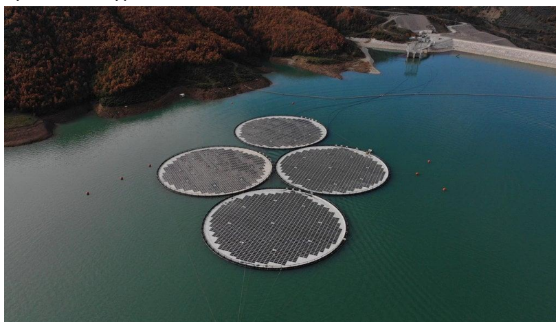
Слика 30. Пловечки фотоволтаици на акумулацијата на хидроцентралата „Бања“ во Албанија
