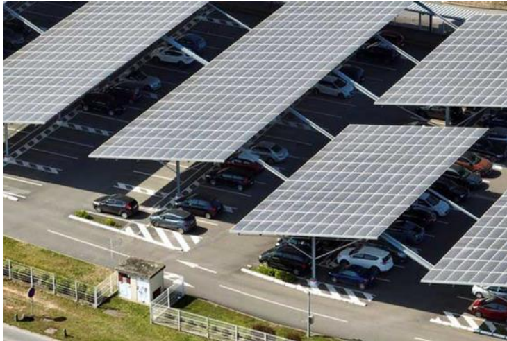
Слика 21. Паркинг со покривна конструкција со фотоволтаици
