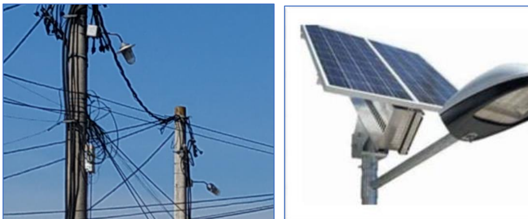
Слика 19. Живини светилки (лево) во Струмица во уличното осветлување и предлог за ново решение – ЛЕД и соларна ќелија (десно)
